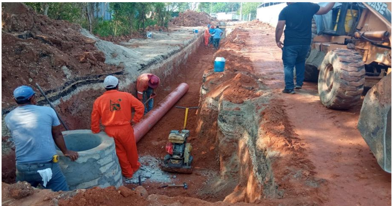
Fotografía 1/2: Rehabilitación Del Colector General De Drenaje Sanitario En Colonia La Unión Carretera Principal
