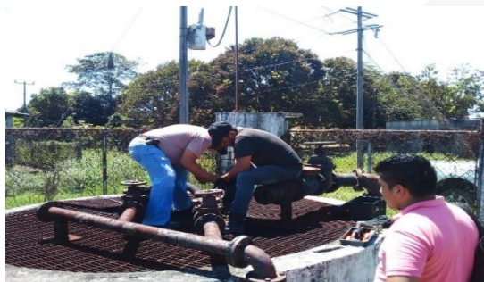
Fotografía: Instalación de bomba sumergible
