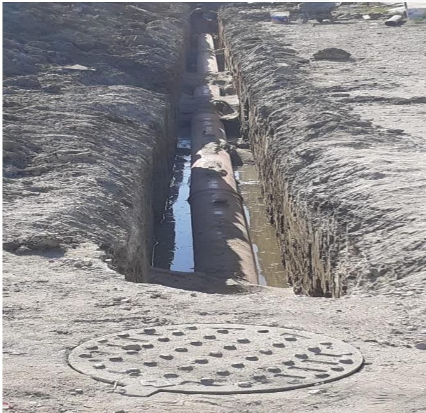
Fotografía: Construcción de drenaje sanitario en la Villa Benito Juárez (San Carlos), Calle Iturbide. Monto: $ 913,611.92
