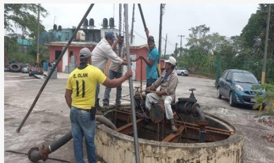
Fotografía: Instalación de bomba sumergible
