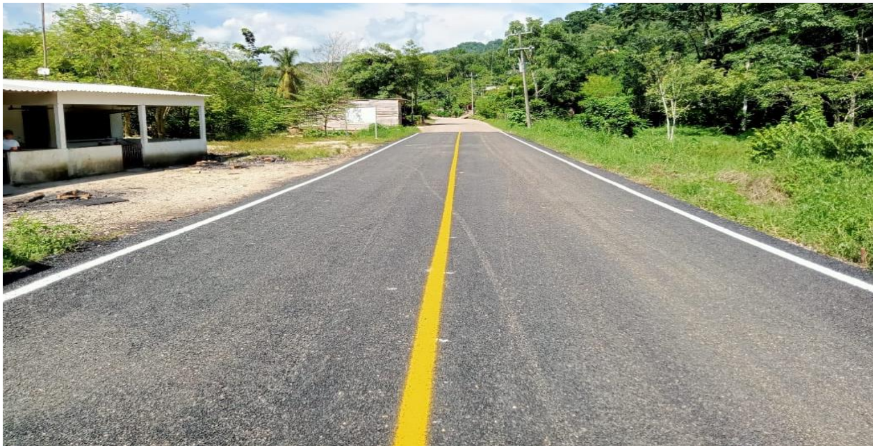
Fotografía: Construcción de Pavimento asfáltico en caliente en Ranchería Melchor Ocampo 1ra Sección. Monto: $3,314,018.48
