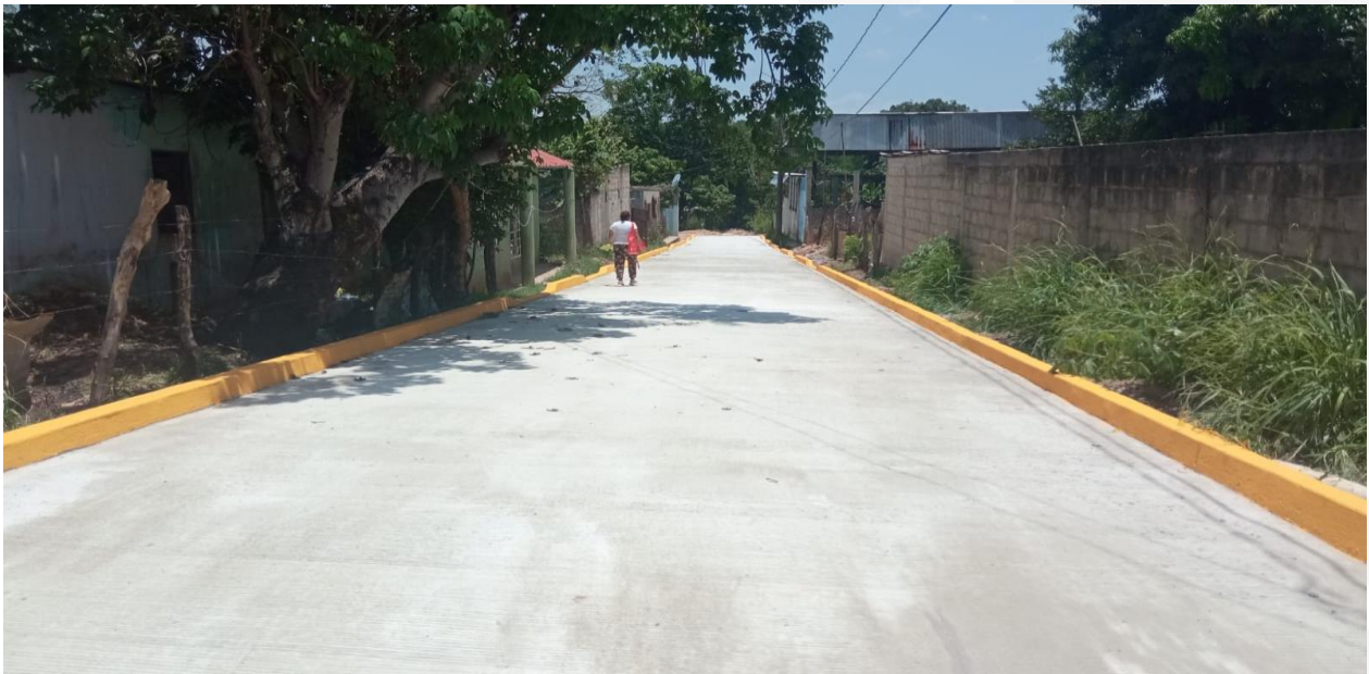
Fotografía: Construcción de guarniciones en Colonia La Escalera, Calle Profesor Fabián Chable. Monto: $659,799.58
