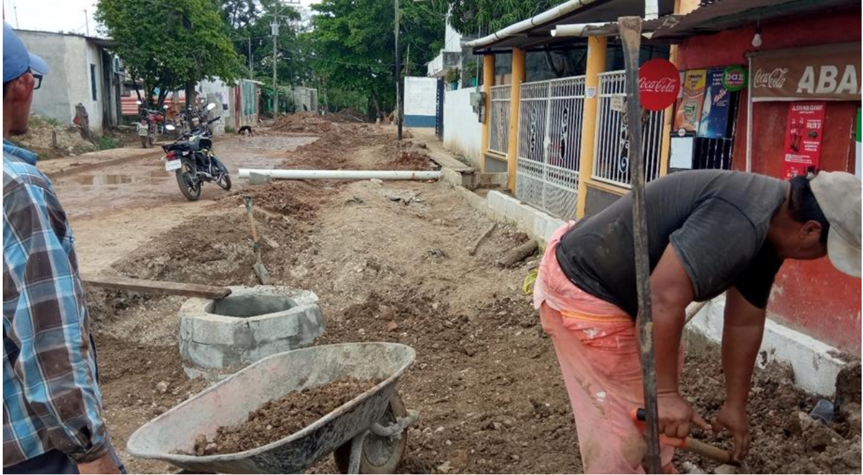
Fotografía: Construcción de Red de Agua Potable en Col. Belén, acceso a la Edificio de Seguridad Pública. Monto: $ 206,834.94
