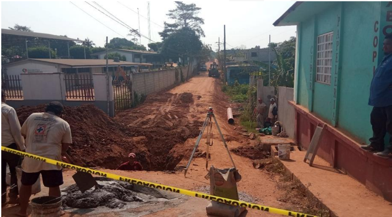
Fotografía 1/2: Construcción de red de drenaje sanitario en Col. La Escalera, Calle Prof. Fabian Chable
