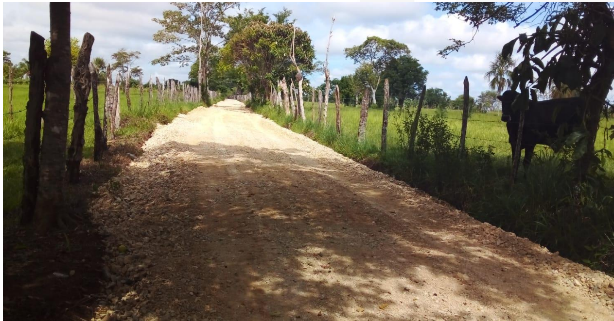
Fotografía: Rehabilitación de Camino, en el Ejido Carmen Serdán Acceso a Col. La Ceiba. Monto: $ 2,542,940.93
