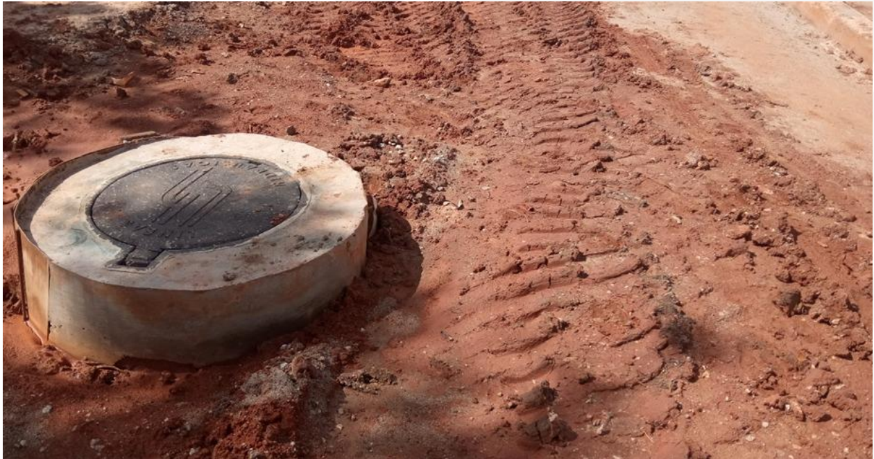
Fotografía 2/2: Construcción de red de drenaje sanitario en Col. La Escalera, Calle Prof. Fabian Chable. Monto: $356,105.82
