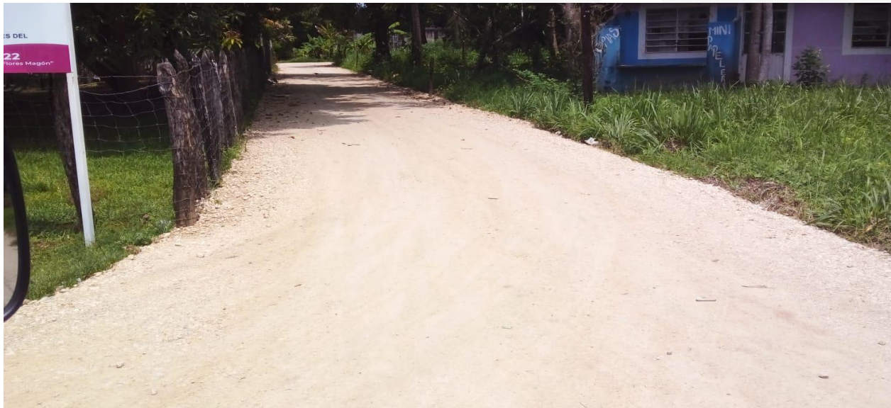
Fotografía: Rehabilitación de calles con grava de revestimiento de 4.15 km en Ranchería el Triunfo 2da Sección. Monto: $1,205,346.66
