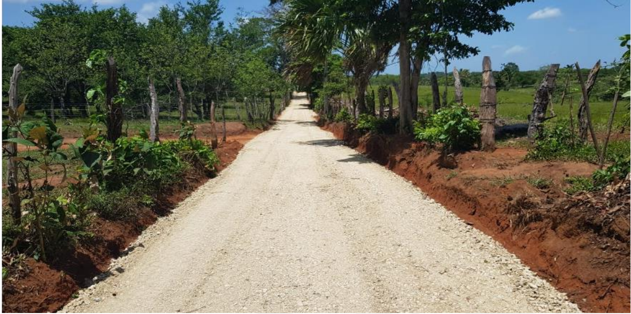
Fotografía: Rehabilitación de Camino en Ranchería Monte Largo 1ra Sección (Diversos Tramos). Monto: $2,346,242.81
