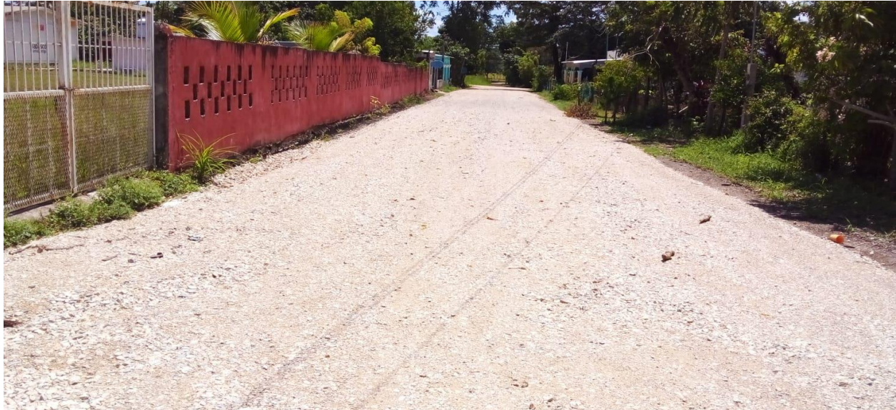
Fotografía: Rehabilitación de calles con grava de revestimiento de 5.26 km en Ejido La Ceiba, Macuspana. Monto: $2,764,566.90
