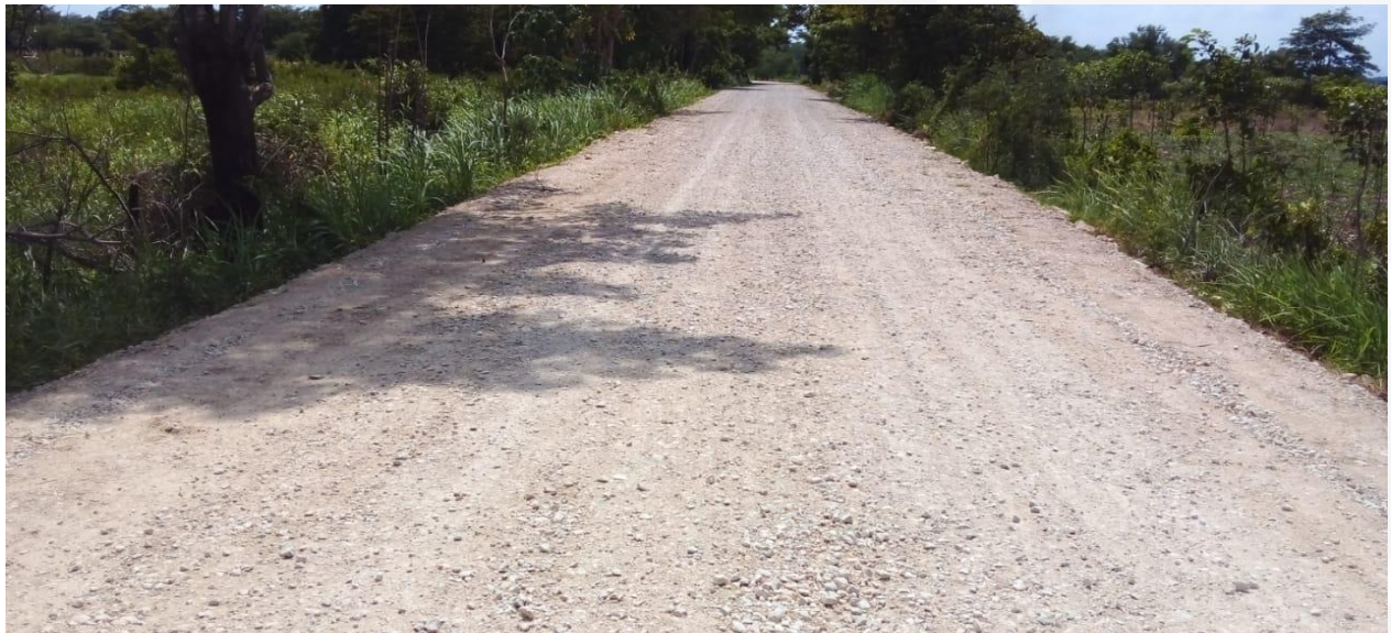
Fotografía: Rehabilitación de Camino en Ranchería Francisco I. Madero Bajo (Sección Naranja). Monto: $3,026,779.25
