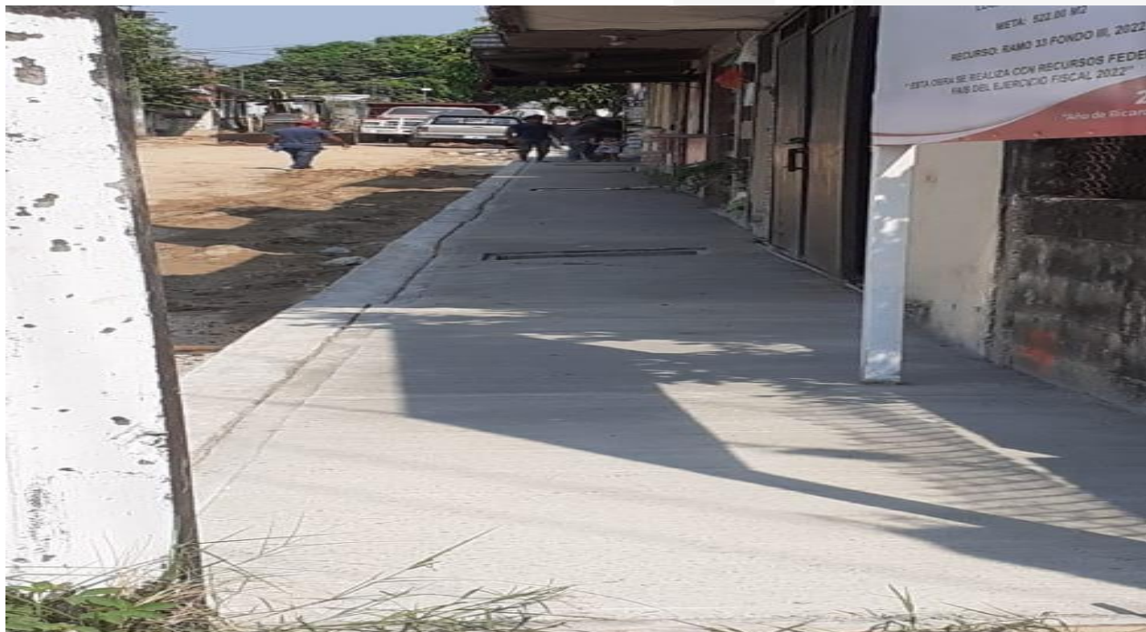
Fotografía: Obra: Construcción de guarniciones y banquetas en Colonia Belén, Calle Josefa Ortiz de Domínguez. Monto $574,442.89
