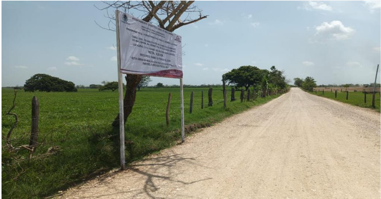
Fotografía: Rehabilitación de Camino en Ranchería Vernet 5ta Sección (San Lorenzo). Monto: $ 1,497,910.35
