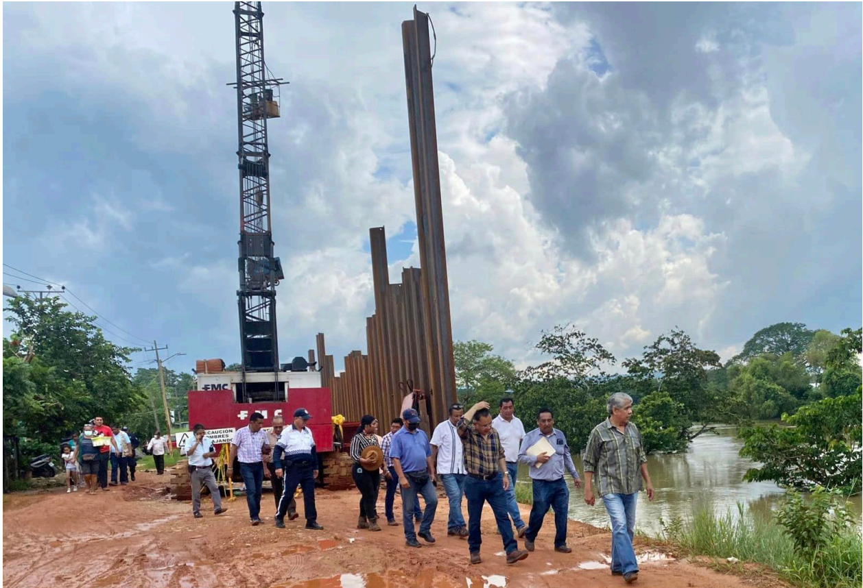
Fotografía: Bordo de Protección de la margen izquierda del río Puxcatán.
