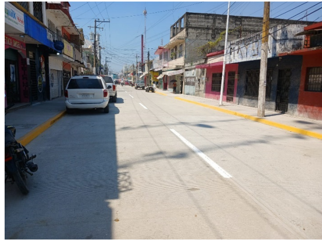
Fotografías: Construcción de pavimento con concreto hidráulico, guarniciones, banquetas, alumbrado público y obras complementarias en la calle Lerdo de Tejada, en el municipio de Macuspana, Tabasco.
